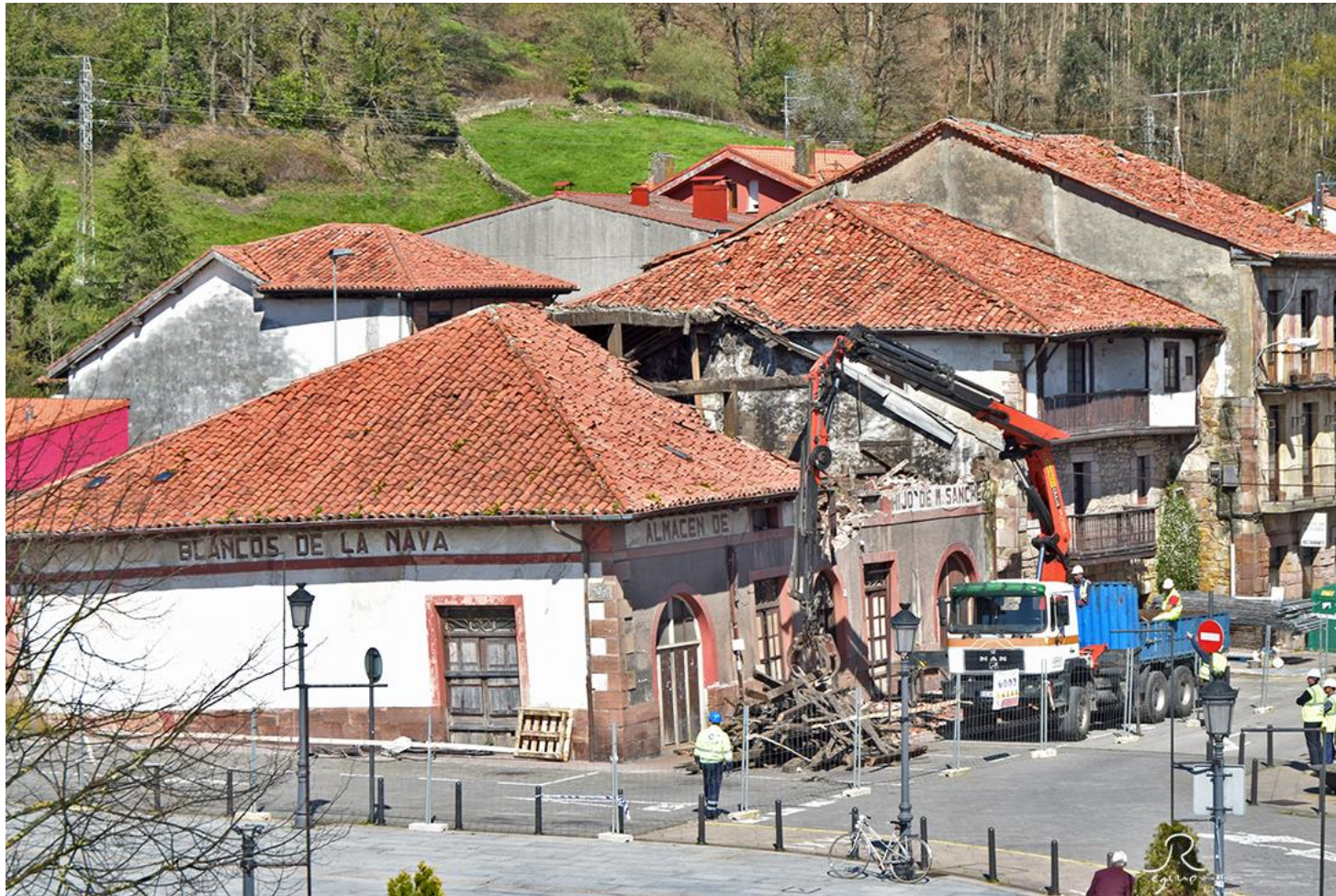
9 - CABEZÓN DE LA SAL 2016 – Demolición almacén de vinos
